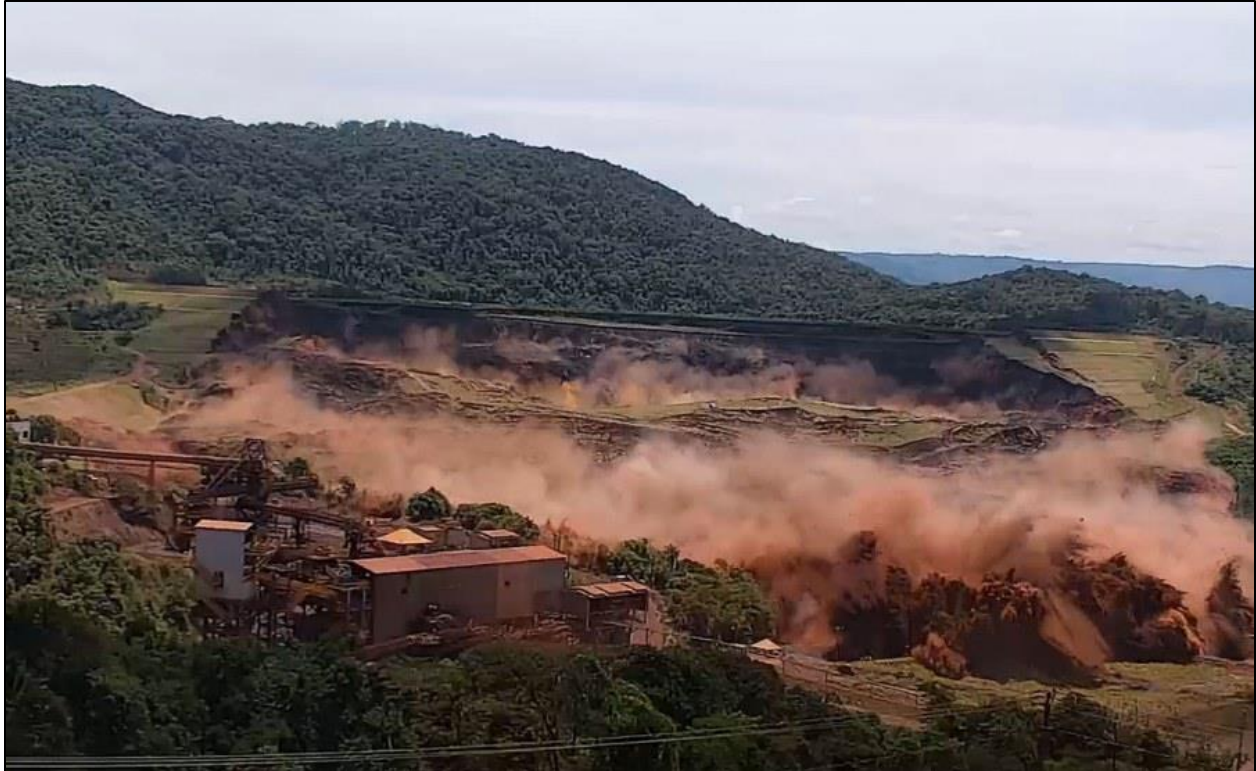
Figura 11. A falha da barragem de rejeitos a montante na mina de Córrego do Feijão, perto de Brumadinho, Brasil, em 25 de janeiro de 2019, que resultou em 272 mortes, incluindo a morte de 258 trabalhadores da mina, foi um momento decisivo na conscientização global sobre o perigo do método de construção a montante. No entanto, nas cinco décadas que antecederam o desastre de Brumadinho, já existiam inúmeros alertas e proibições sobre o uso do método de construção a montante em documentos de orientação e regulamentações. Foto de Robertson et al. (2019).
